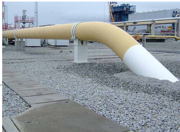
Røret går ned i bakke
